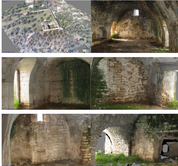
Nuvola di punti e mesh ottenute attraverso tecnica fotogrammetrica (tesi di Domenico Modugno, Il rilievo del costruito nel BIM, 2016)
